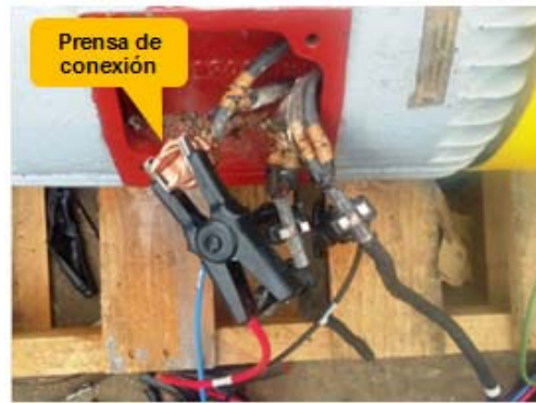
Imagen 8, instalación de prensa partida.
