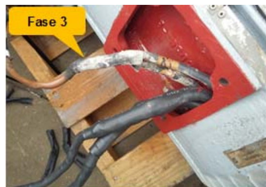
Imagen 1, cables terminales de conexión.
